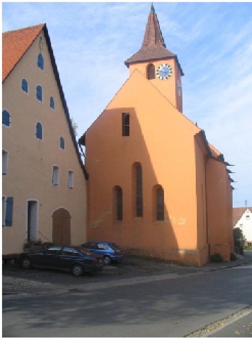
oben: St. Johanneskirche ehem. Konventgebäude
